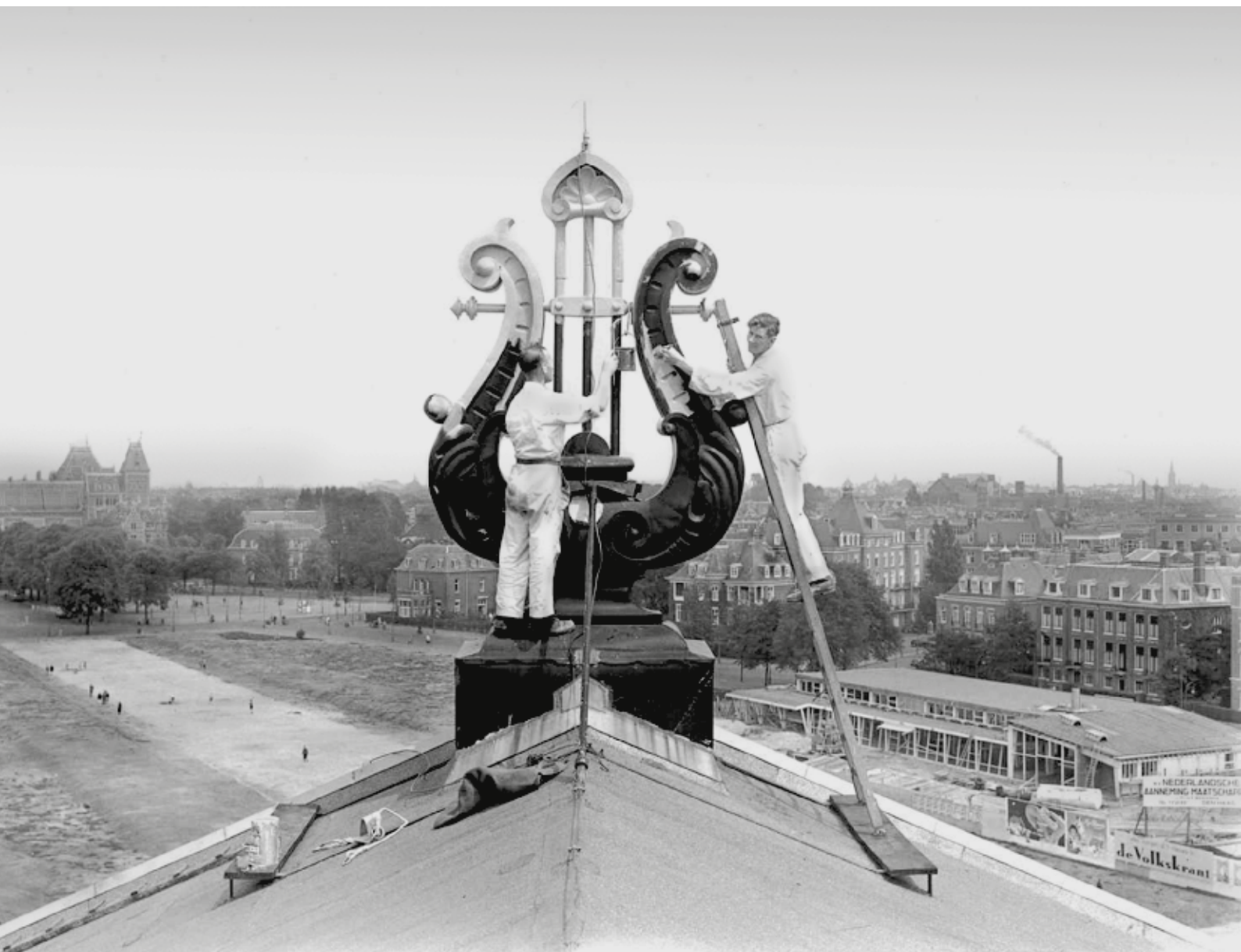
Arbeiter restaurieren 1953 die Harfe auf dem Dach des Concertgebouw Amsterdam.
